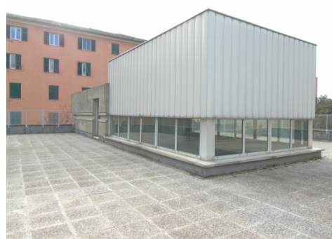
Figura 4.2 - Particolare delle coperture praticabile e dei pannelli sandwich in lamiera coibentata
