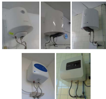
Figura 4.13 - Particolari di boiler elettrici per la produzione di acqua calda sanitaria
