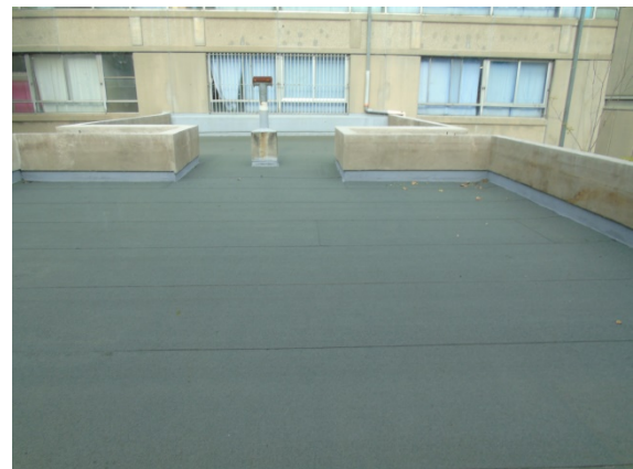
Figura 8.3 - Particolare copertura piana su cui intervenire
