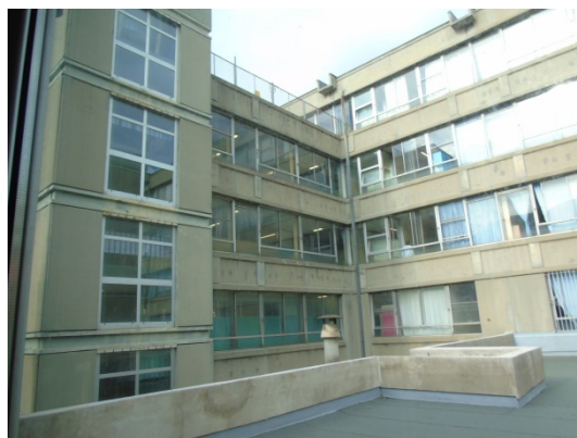
Figura 1.1 - Vista delle facciate esposte a est e sud
