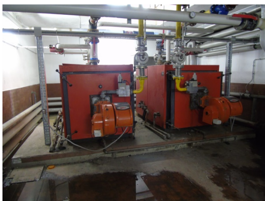
Figura 4.11 - Generatori di calore
