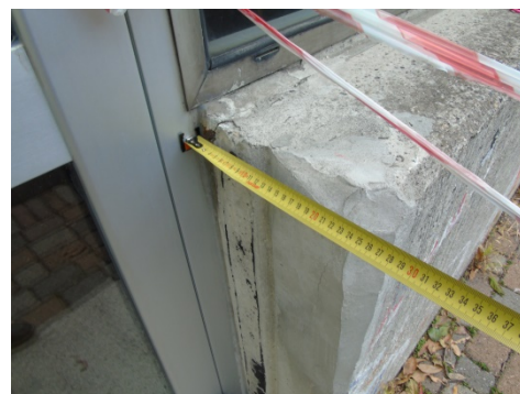
Figura 4.1 - Particolare della muratura perimetrale e della struttura portante in pilastri di acciaio
